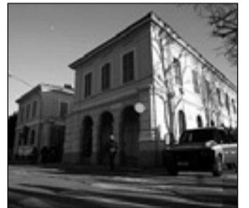
La palazzina di piazzale Allende
